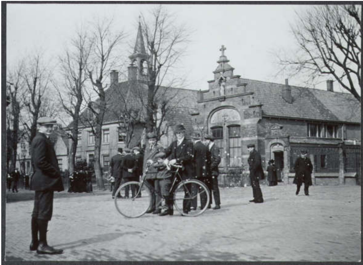
Links de oude pastorie met daarachter de kerk met dakruiter, rechts de oude Sint Josephschool, de foto dateert van vlak voor de sloop van de panden in 1914
