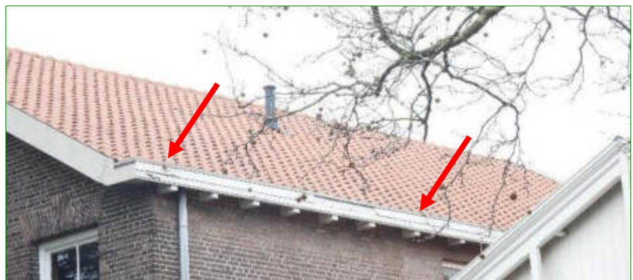
De openingen onder de dakpannen (rode pijlen) van de bebouwing geven mogelijk toegang tot voor Huismus geschikte achterliggende ruimtes.
