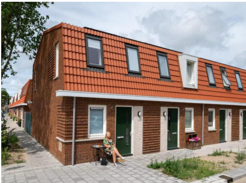
Inspiratiebeeld detaillering, Zonnelaan Wormerveer. Textuur in de baksteen, een accentkleur bij de deuren, een opvallende goot.
